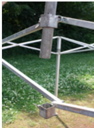
10. Federbeine m. d. langen Seite nach unten einführen und mit 1 Schraube fixieren !
